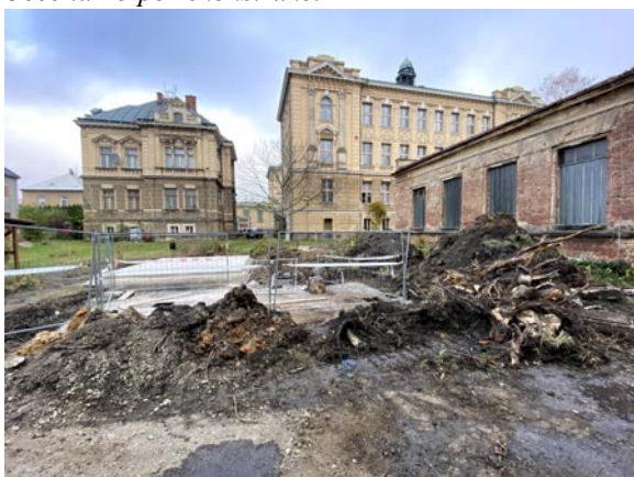
Budování sportovního a relaxačního centra BGV
