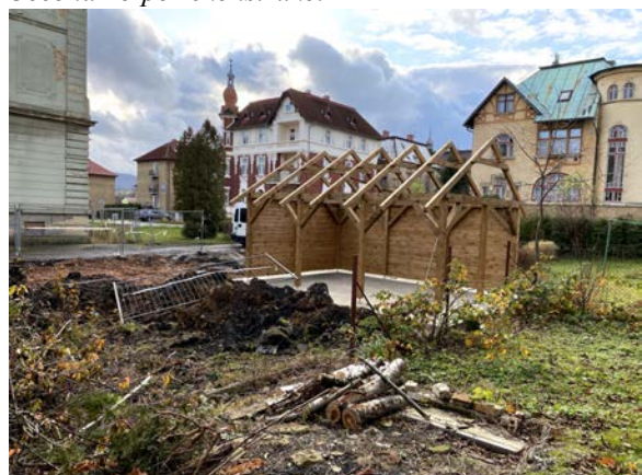
Budování sportovního a relaxačního centra BGV
