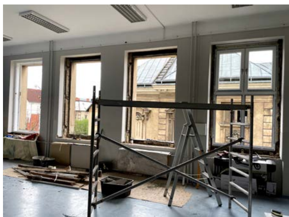
Učebna č. 38 v průběhu rekonstrukce
