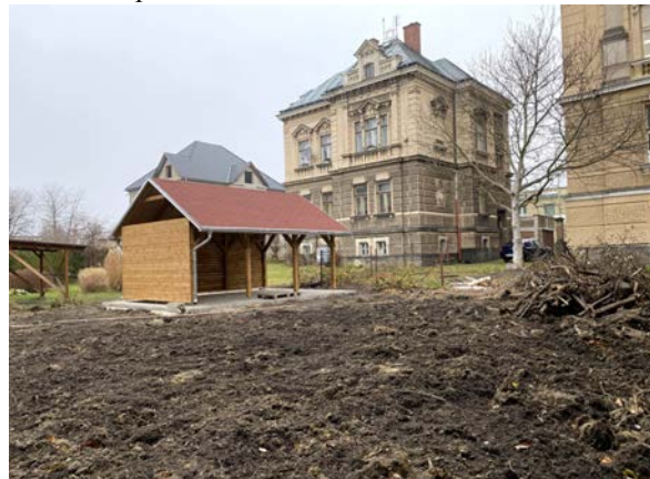
Budování sportovního a relaxačního centra BGV
