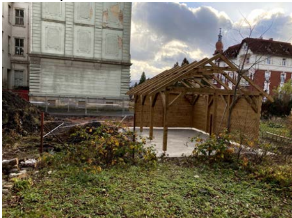
Budování sportovního a relaxačního centra BGV
