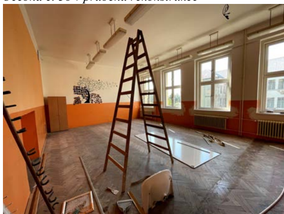
Učebna č. 37 v průběhu rekonstrukce
