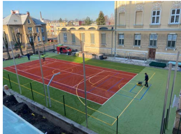
Rekonstrukce školního hřiště
