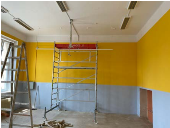
Učebna č. 25 v průběhu rekonstrukce
