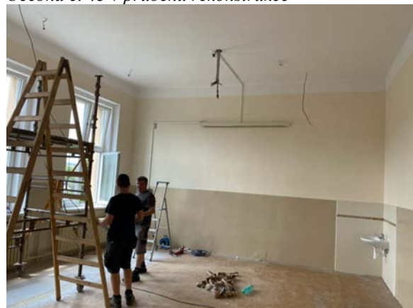
Učebna č 43 v průběhu rekonstrukce
