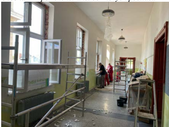
Výměna oken na chodbách v 2. NP
