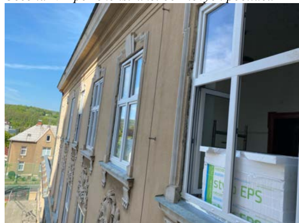
Výměna oken na chodbách v 2. NP
