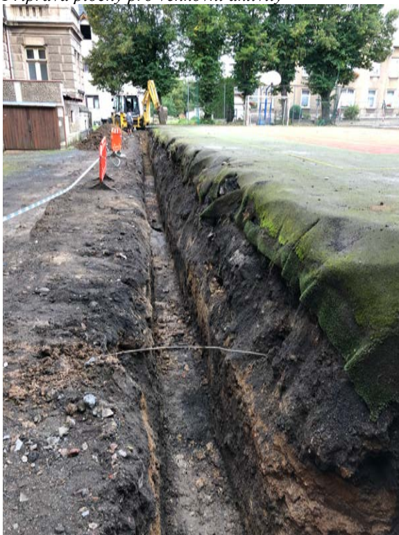
Výstavba opěrné zdi
