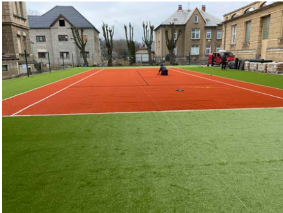
Rekonstrukce školního hřiště
