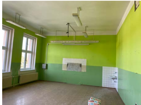
Učebna č. 43 v průběhu rekonstrukce
