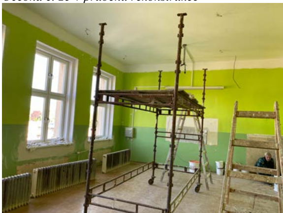
Učebna č 43 v průběhu rekonstrukce
