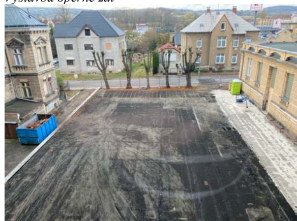
Rekonstrukce školního hřiště
