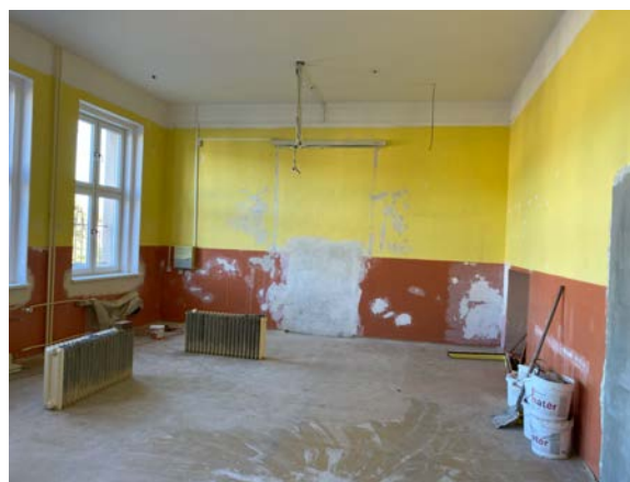
Učebna č. 25 v průběhu rekonstrukce
