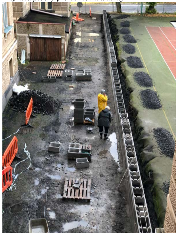
Výstavba opěrné zdi
