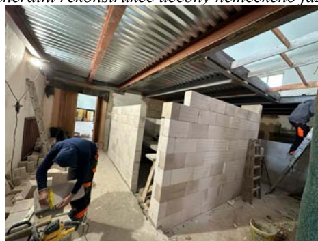
Generální rekonstrukce sociálního zařízení a šaten tělocvičny
