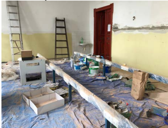
Učebna IVT v průběhu rekonstrukce
