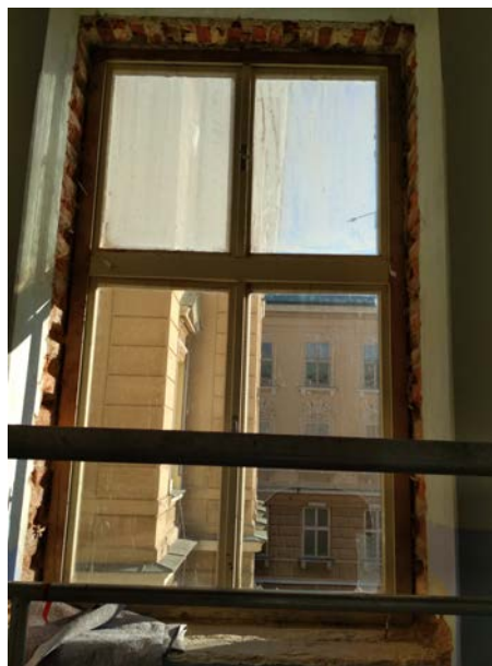
Výměna oken na chodbách v 1. NP
