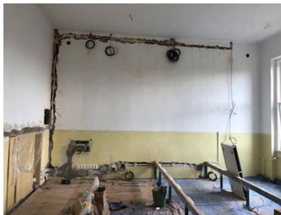
Učebna IVT v průběhu rekonstrukce
