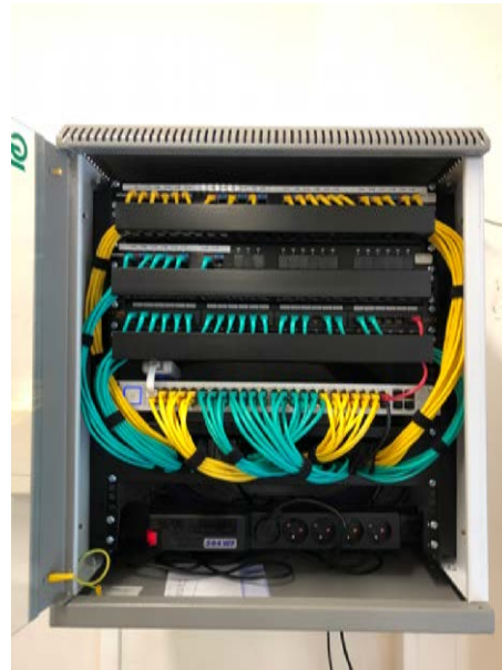
Rekonstrukce IT rozvaděčů včetně nových technologií
