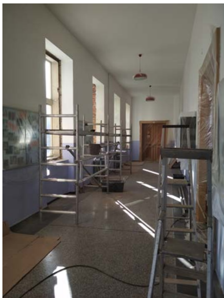
Výměna oken na chodbách v 1. NP
