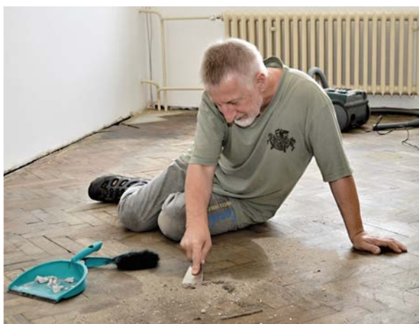
A ještě jednou 18. 8. 2019 – příprava na položení nového koberce...
