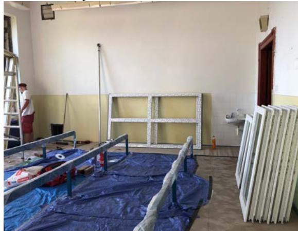
Učebna IVT v průběhu rekonstrukce
