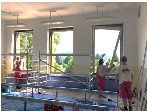
Učebna IVT v průběhu rekonstrukce
