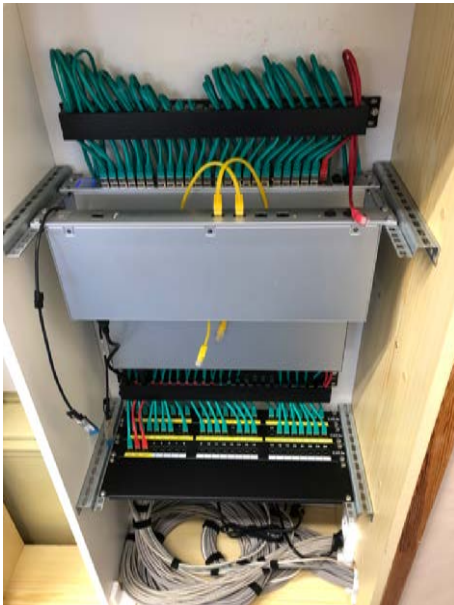
Rekonstrukce IT rozvaděčů včetně nových technologií
