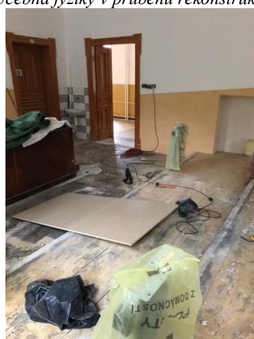
Učebna fyziky v průběhu rekonstrukce
