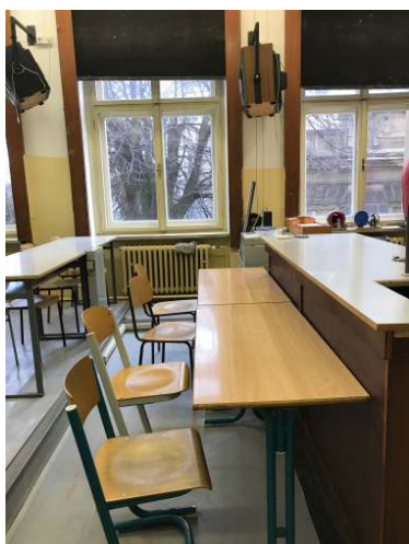
Učebna fyziky před rekonstrukcí
