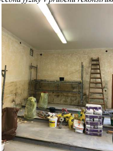
Učebna fyziky v průběhu rekonstrukce
