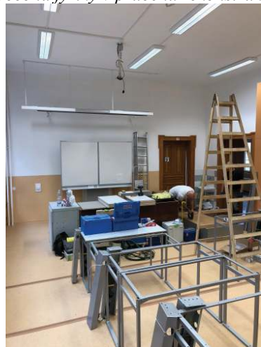
Učebna fyziky těsně před dokončením
