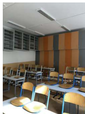
Rekonstrukce učebny fyziky
