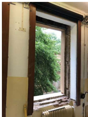
Učebna fyziky v průběhu rekonstrukce
