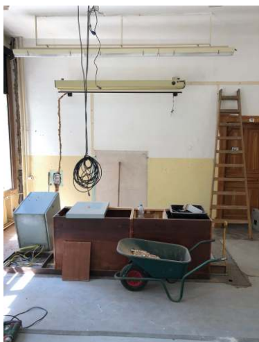
Učebna fyziky v průběhu rekonstrukce
