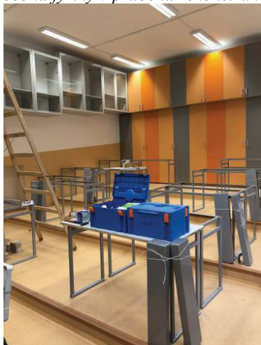
Učebna fyziky těsně před dokončením
